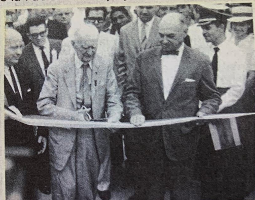
Por designación de las autoridades de la extinta Zona del Canal, Maurice Thatcher hace el corte inaugural del puente de las Américas, lo acompaña el gobernador de la extinta Zona del Canal, Robert Fleming.
