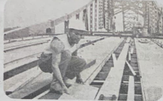
A mediados de 1961, el Puente de Las Américas ya mostraba su belleza arquitectónica.
